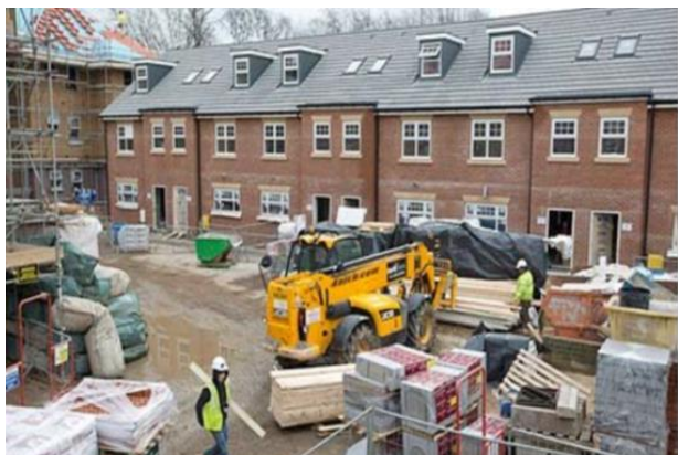
住宅建設現場 / ウェールズ
