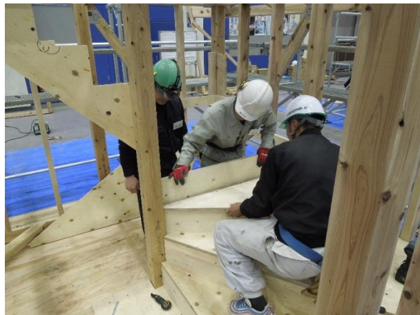
実技用モデルを用いた作業用階段の取付
