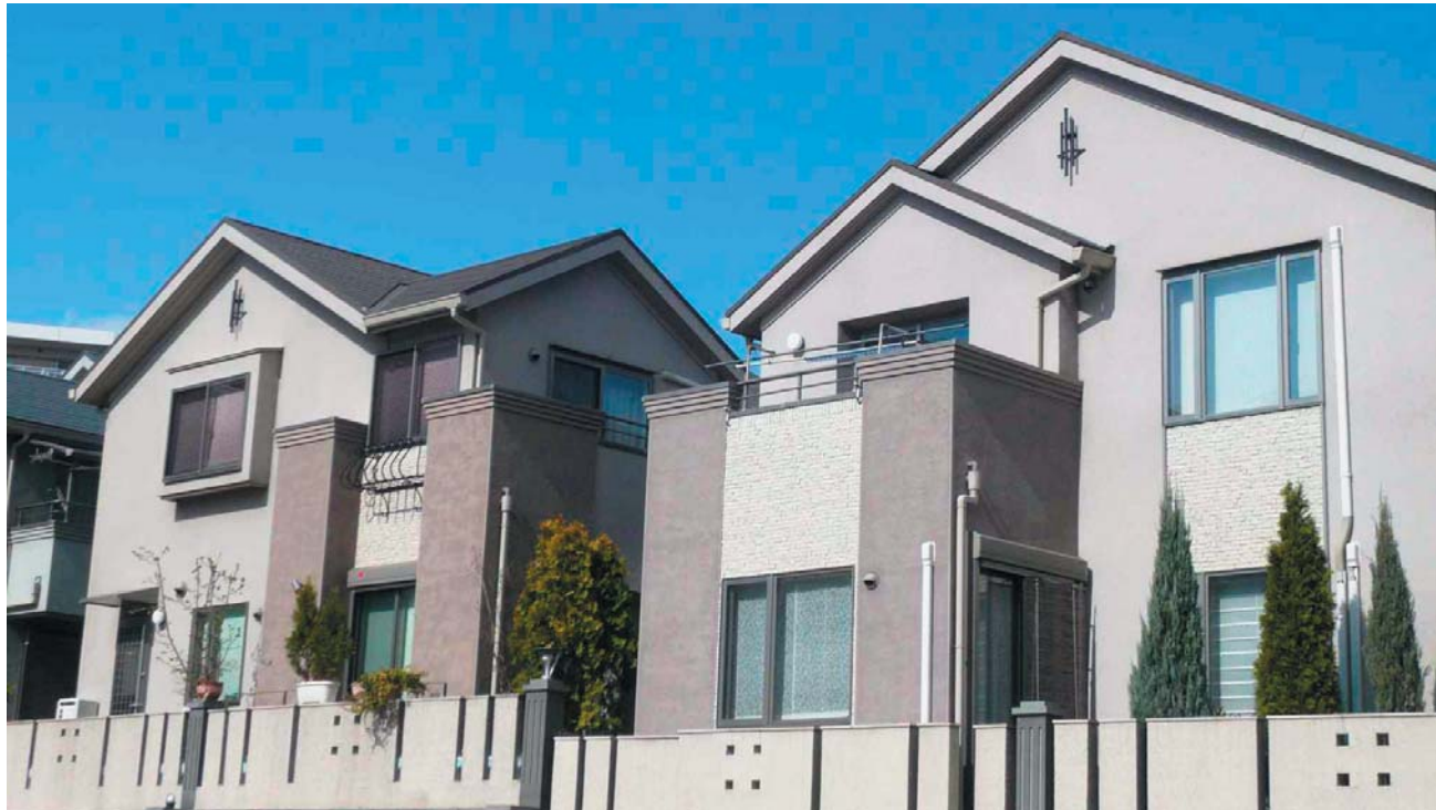
大壁工法施工例
