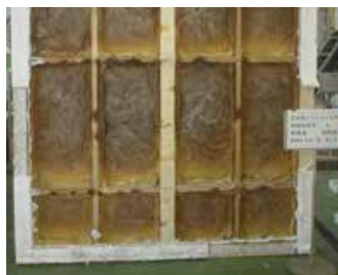
加熱試験後の壁内部
