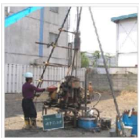
ボーリング調査
