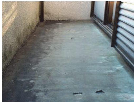
防水層の破断
