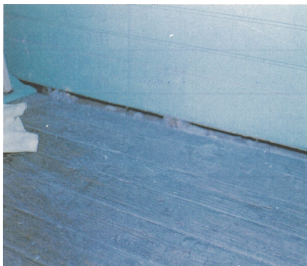
床の沈みが想定される床と壁との取り合い部の隙間
