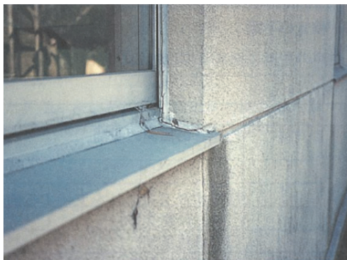
シーリング材の破断による建具周囲の隙間
