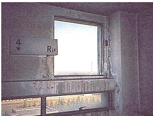
階段室内壁の雨漏りの跡
