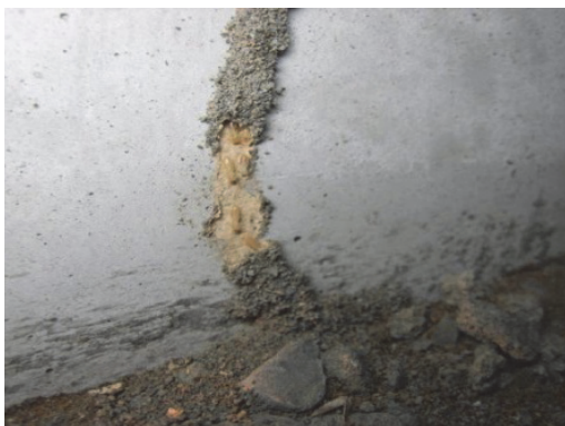
基礎立上り部に形成された蟻道
