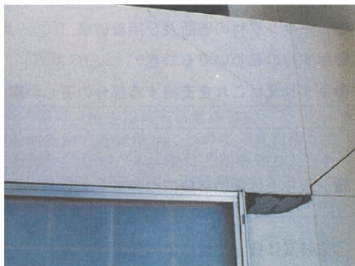
外壁の深さ 20 mm以上のひび欠損 出典 『住宅性能表示制度 建設住宅性能評価解説（既存住宅・現況検査）2016』（一財）日本建築センター編集
