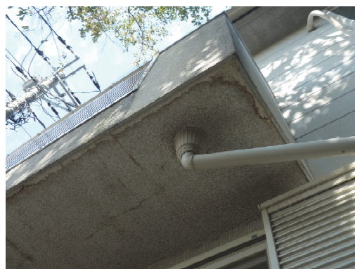
バルコニー床下面の雨漏り跡
