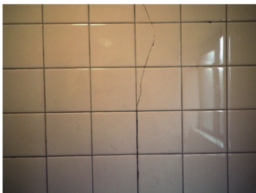
タイルの下地材まで到達しているひび割れ
