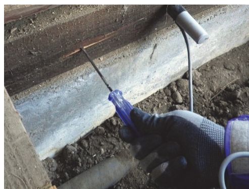
土台の蟻害・腐朽の有無の調査状況
