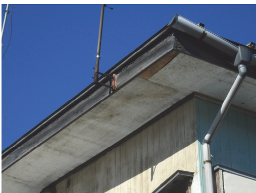
軒裏天井の雨漏り跡
