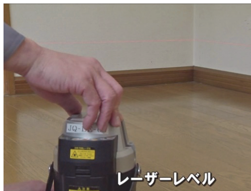
床の傾斜のレーザーレベルによる計測状況
