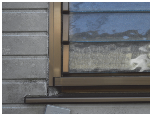
建具縦枠の建具の周囲の隙間
