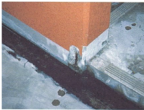
外壁の鉄筋の露出
