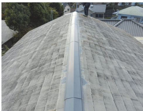
スレートの劣化
