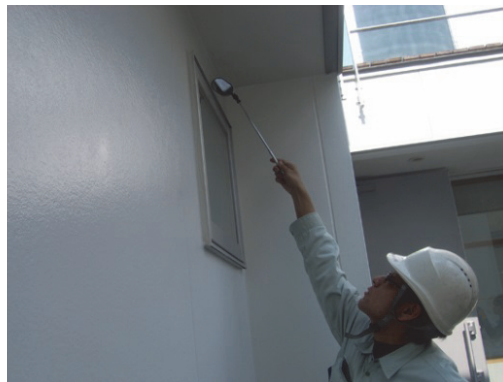
点検鏡による開口部天端部分のシーリング材の目視状況
