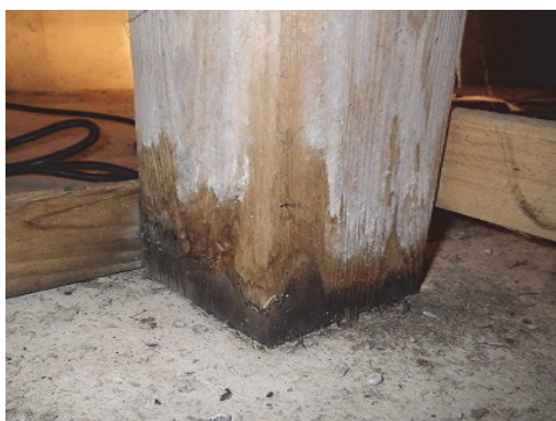
床束の腐朽
