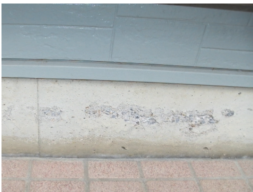
コンクリートの広範囲の欠損
