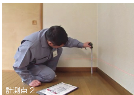
レーザーレベルによる床の傾斜の計測状況
