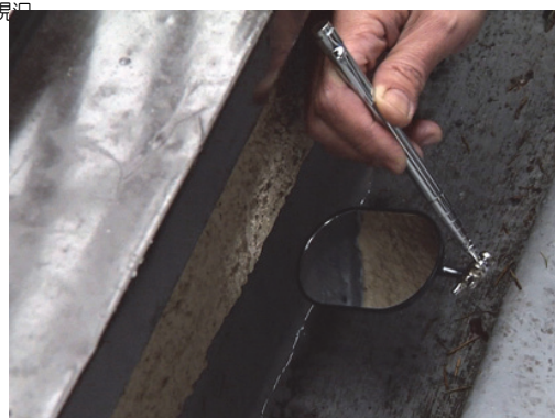
バルコニー防水端部納まりの確認
