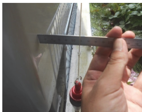
下げ振りによる壁の傾斜の計測状況
