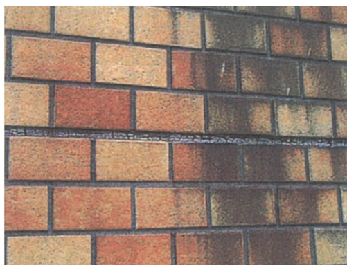
シーリング材の破断
