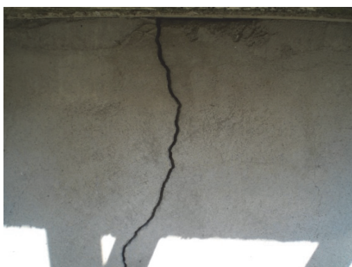
基礎の幅 0.5 mm以上のひび割れ
