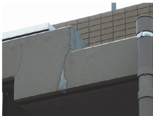
ひび割れ部分に生じている白華（エフロレッセンス）
