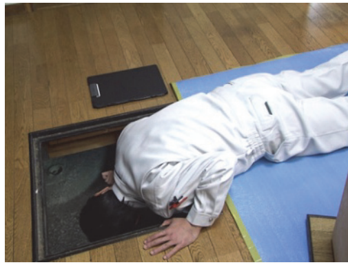
床下点検口（収納庫）からの覗きこみによる目視状況
