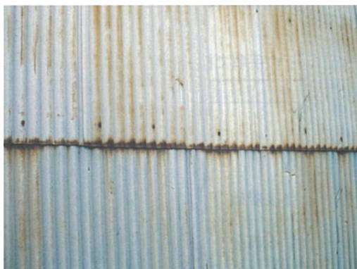
金属製の板状の仕上げ材の著しいさび
