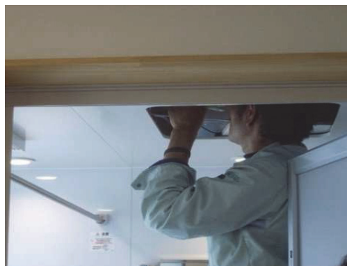
ユニットバス天井点検口からのからの床の目視状況
