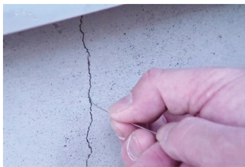
ひび割れの深さの計測状況
