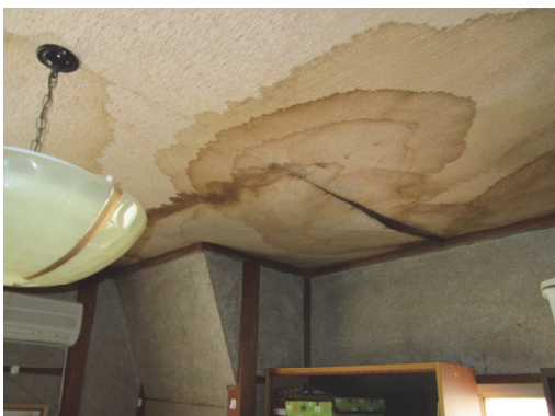
天井の雨漏り跡
