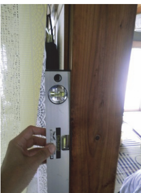
柱の傾斜の水平器による確認状況
