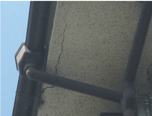
モルタル仕上げの軒裏の下地材まで達しているひび割れ
