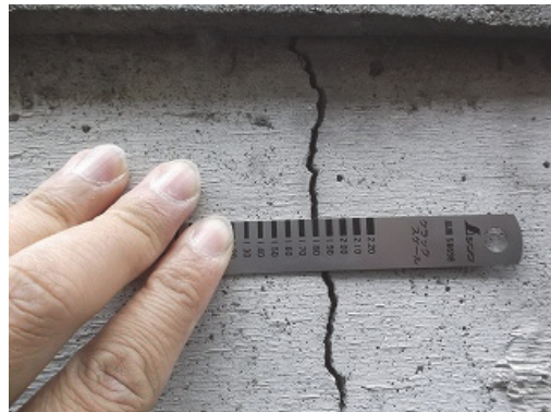
ひび割れ幅のクラックスケールによる計測状況
