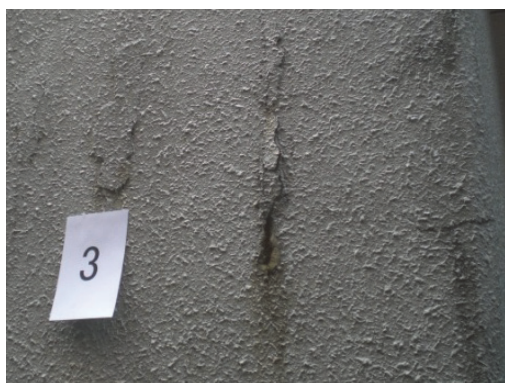
外壁のさび汁を伴うひび欠損
