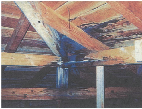
小屋組の腐朽
