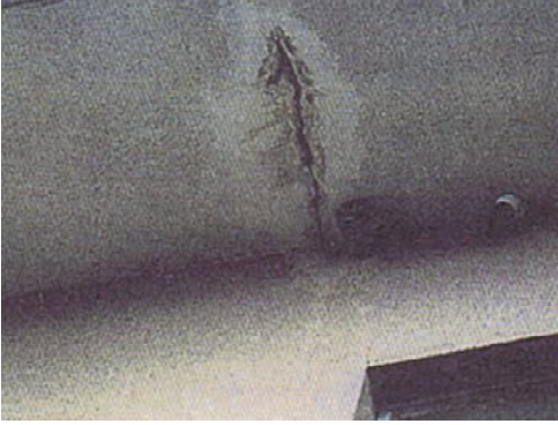
バルコニーあげ裏の鉄筋の露出
