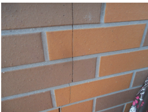
複数のタイルに連続して生じたひび割れ
