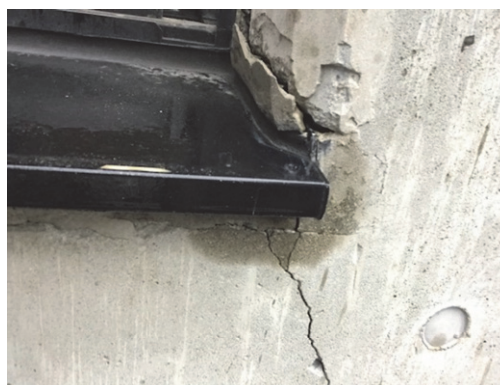
外壁の幅 0.5 mm以上のひび割れ
