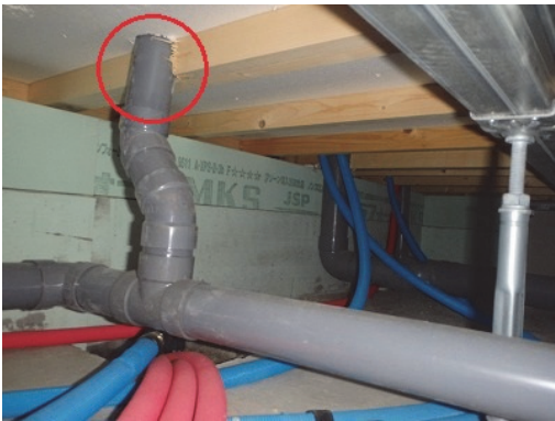
根太の排水管による欠損
