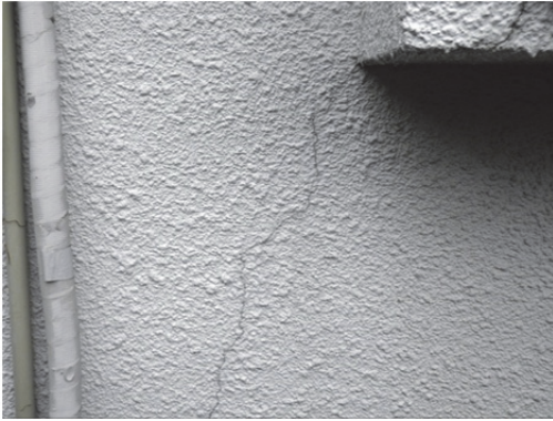
モルタル仕上げの外壁の下地材まで達しているひび割れ
