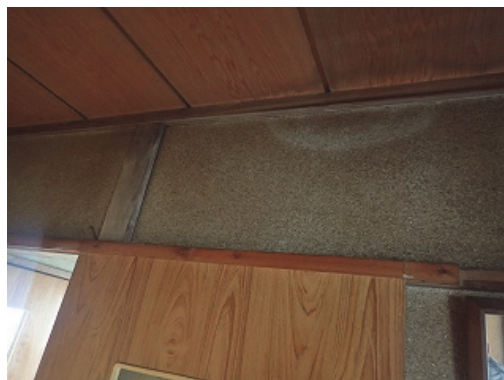
内壁の雨漏り跡
