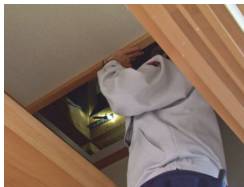
天井点検口からの覗きこみによる目視状況
