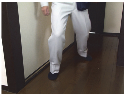
歩行による床の沈み状況の確認
