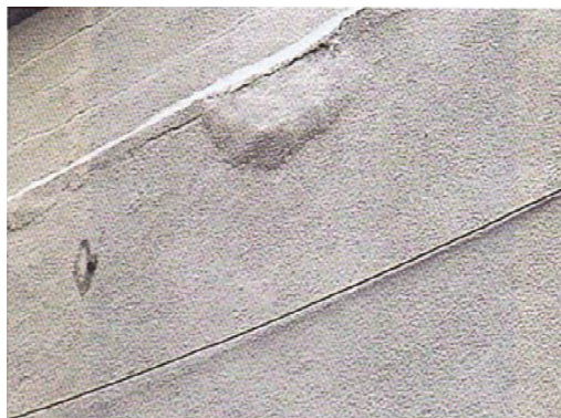
塗壁材の著しい浮き
