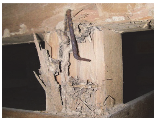
床束に付着した蟻土及び床組の食害
