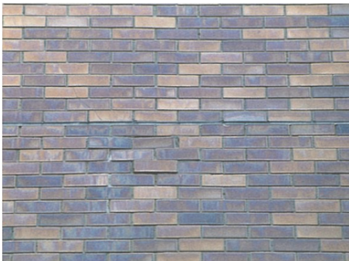
タイル仕上げの著しい浮き
