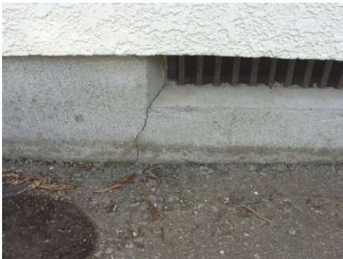
幅 0.5 mm以上のひび割れ
