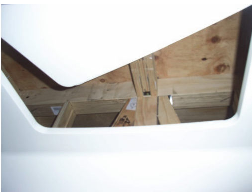
天井点検口からの覗きこみによる目視状況
