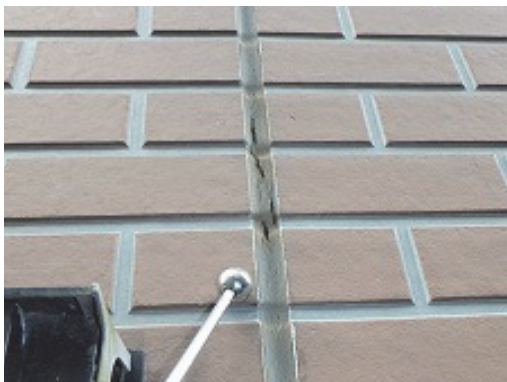
シーリング材の破断
