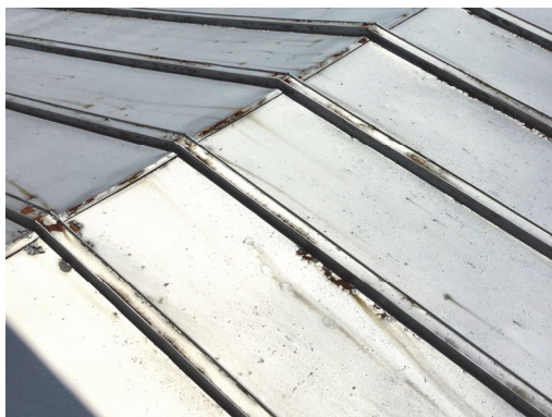
金属系屋根葺き材の劣化
