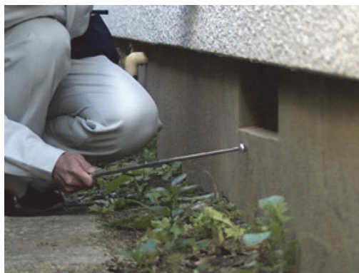
基礎コンクリートの打診の状況
