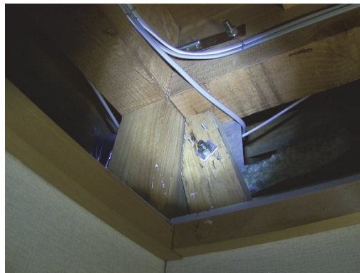
小屋裏内における接合部の構造方法・接合状態の目視状況
