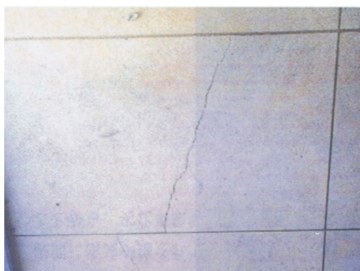
床の著しいひび割れ
