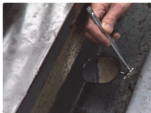
バルコニーの防水層の目視状況
