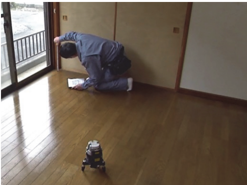
床の傾斜のレーザーレベルによる計測状況
