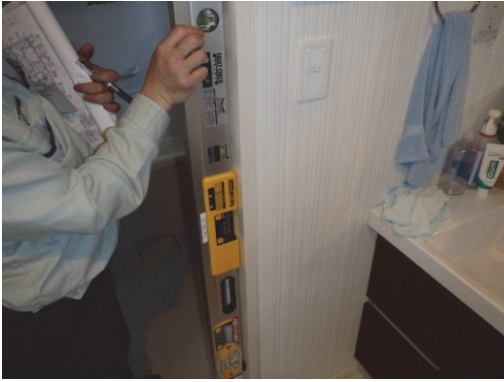
内壁の傾斜のデジタル水準器による計測状況
