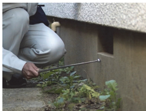
コンクリート部浮きの打診状況
