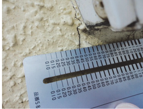
ひび割れ幅のクラックスケールによる計測状況
