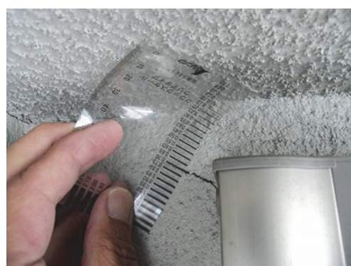
壁のひび割れ幅の計測状況
