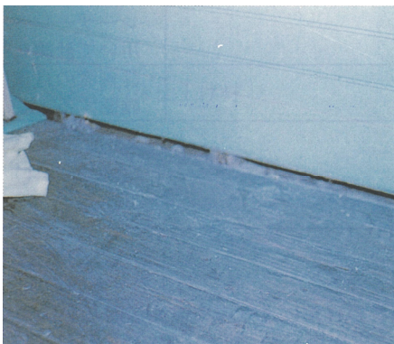
床の傾斜が想定される床と壁との取り合い部の隙間
