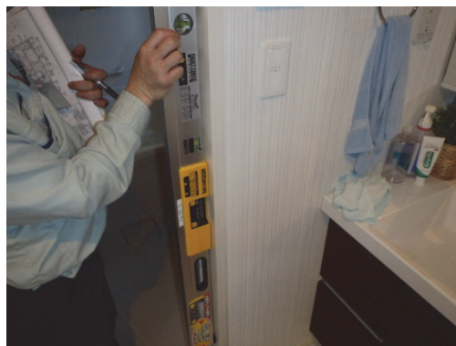
デジタル水準器による傾斜の計測状況
