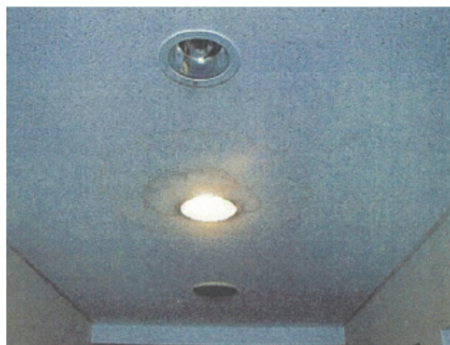
共用廊下の天井の雨漏りの跡
