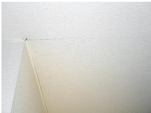
壁紙の下地材まで到達しているひび割れ
