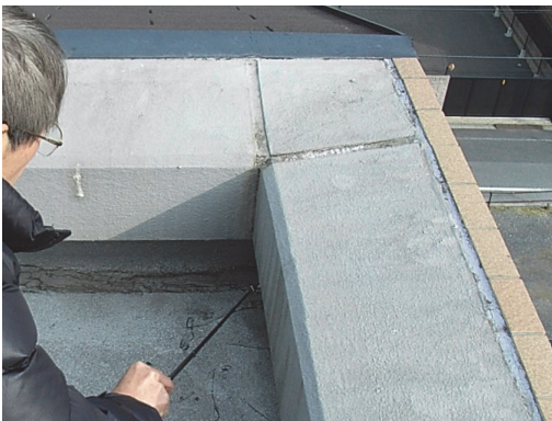
屋根防水端部の確認状況
