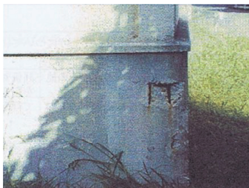
基礎の鉄筋の露出
