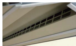
大きな開口が多数並び棟換気の内側
