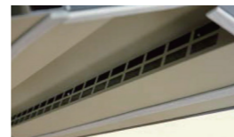
大きな開口が多数並び棟換気の内側
