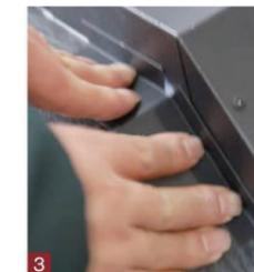
3 棟換気本体の妻側に付属のアンダー捨水切をシーリング剤で留付けます。
