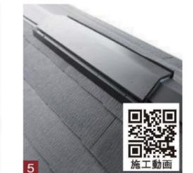
5 専用棟を施工して継ぎ目をシーリング剤を施せば完成です。
