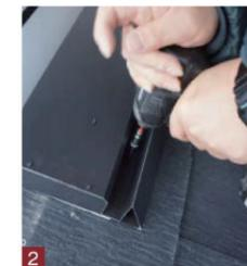
2 捨水切のセンター合わせで棟換気本体を仮置きし付属の本体固定ビスにて留付けます。
