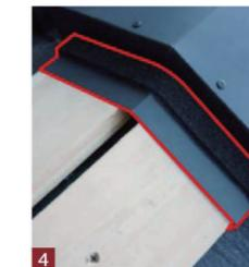
4 笠木を施工して付属のアンダー捨水切を笠木に取り付けます。
