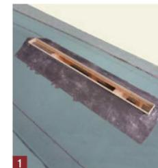
1 開口を開け、屋根下葺材を置きます。捨水切を作成して開口に合わせて施工します。周りを防水テープで防水処理します。
