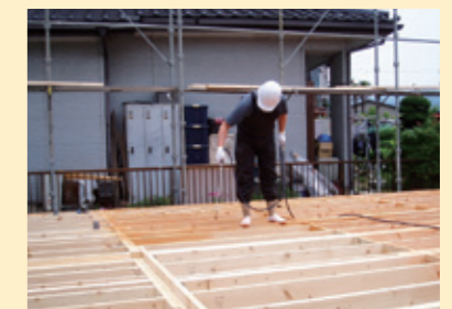
木材保存剤／シロアリ工事
