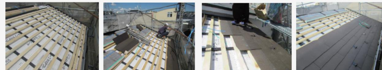
実現場において、施工時の桧木、屋根材の割れ、施工後の屋根材の割れがない事を確認しました。
