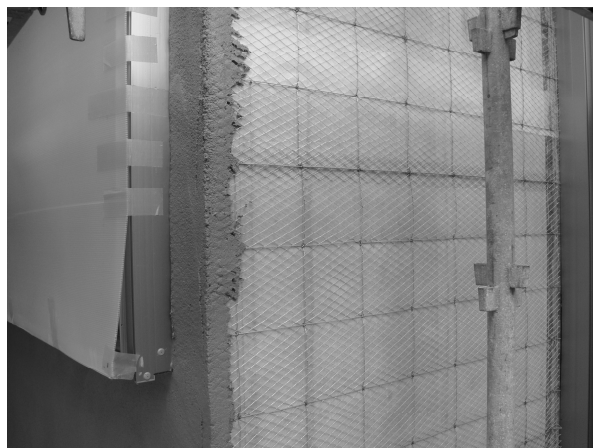
写真110-1 メタルラス下地
