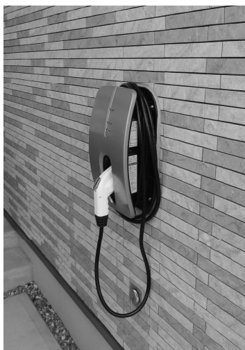
写真47-1 壁面取付けタイプ
