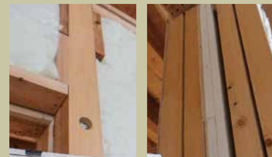
防火壁の耐火部と一般部の接合部
