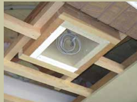
軒天 埋込み型照明器具下地
