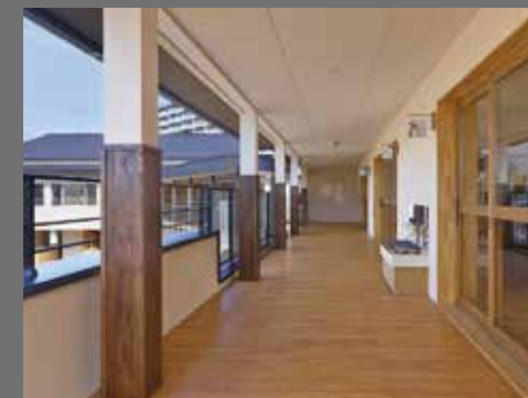
2階デッキスペース
