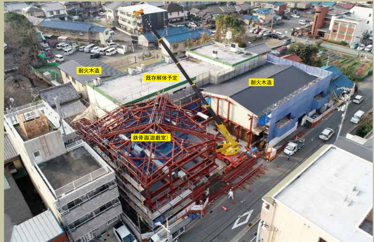
既存園舎を使用しながら、鉄骨造・耐火木造施工中
