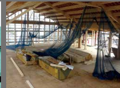
工事中 (遊戯室)
