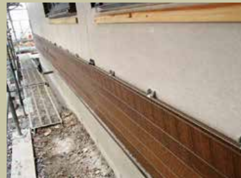
外壁(耐火建築物)
