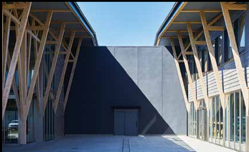
写真中央部が2時間耐火構造
