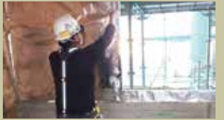
ALGC張り施工
