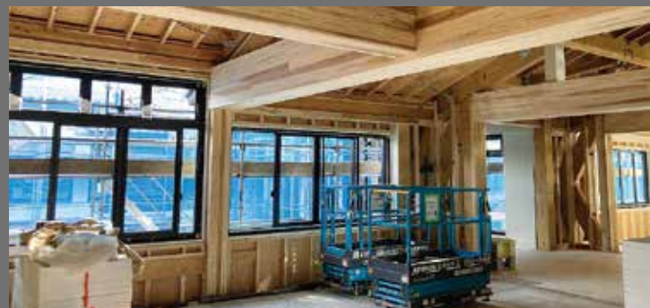
工事中(フードコート)
