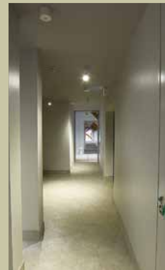
渡り廊下(2時間耐火)2階内部
