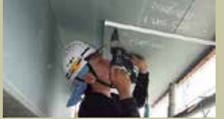
軒天耐火木造部分施工状況
