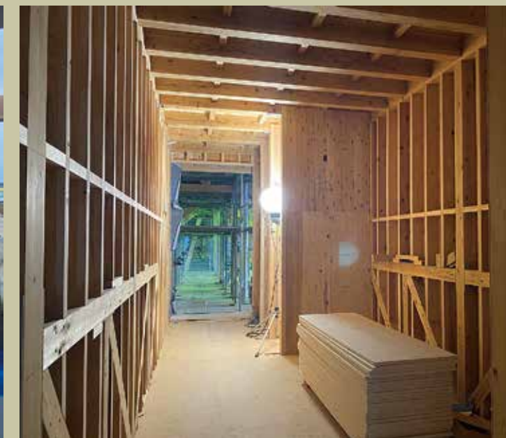
渡り廊下 木軸工事完了状況 2階内部
