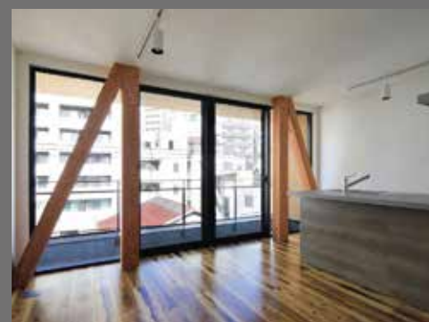
筋かいと間柱のあらわし(鉛直荷重を受けていない)
