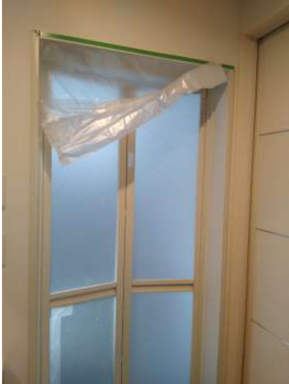
マスカーを使った養生
