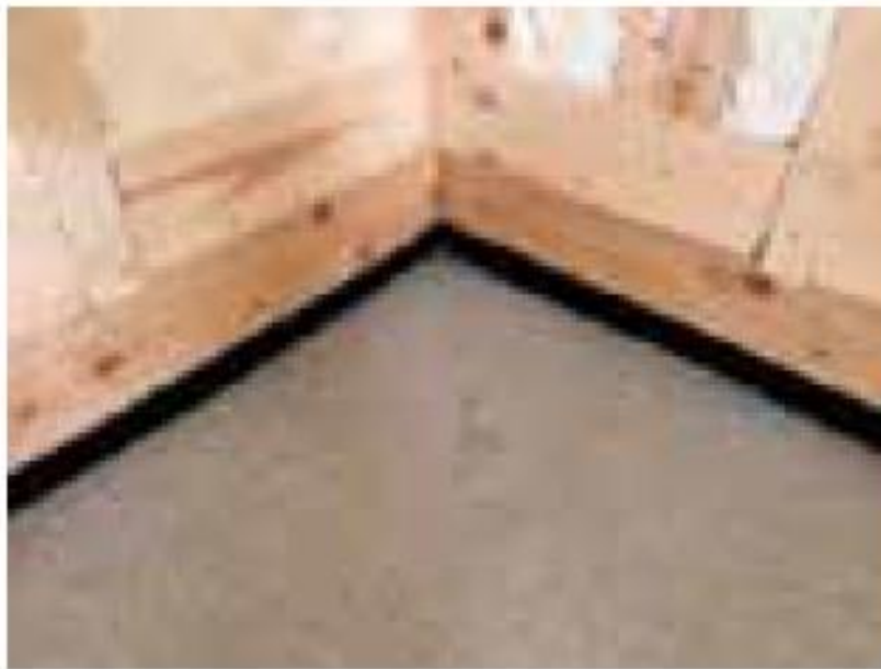
玄関土間と気密基礎パッキン部の気密化 (気密テープの例)
