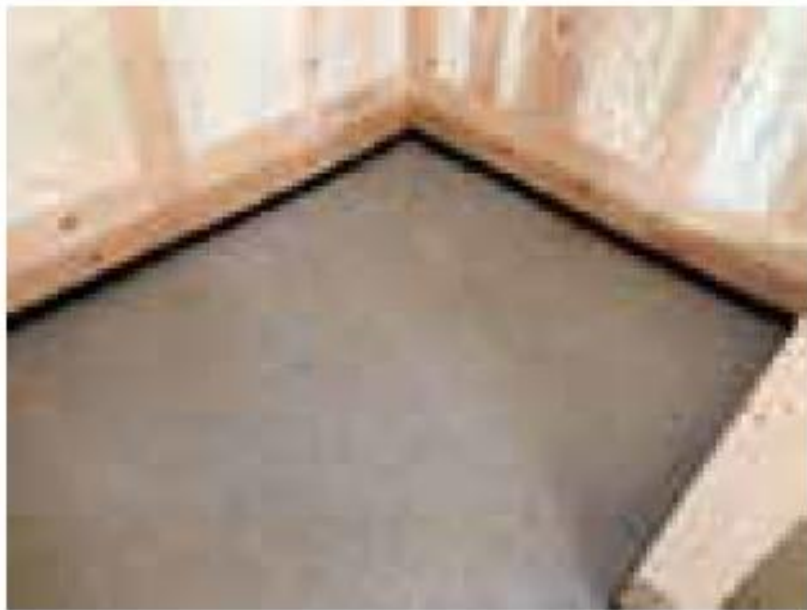
玄関土間と気密基礎パッキン部の気密化 (気密テープの例)
