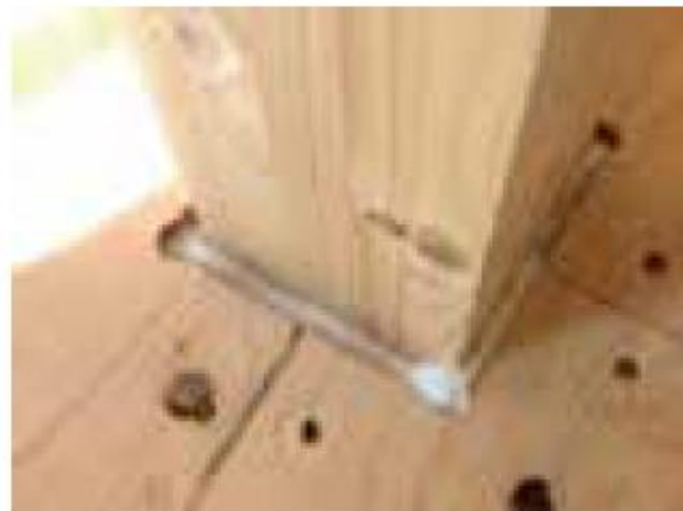
剛床と柱・間柱の隙間の気密化施工【床断熱工法】
