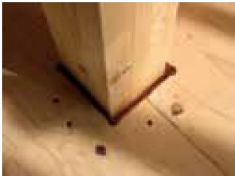
剛床と柱・間柱の隙間の気密化施工【床断熱工法】
