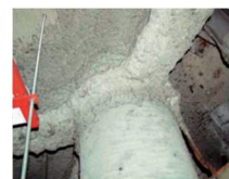
吹付け石綿 （鉄骨材の耐火被覆）
