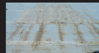
金属屋根の下 ルーフィングの水分による錆模様
