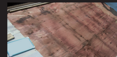
防水層の下 野地板の腐朽
