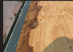
軒先 雨水の毛細管現象による変色
