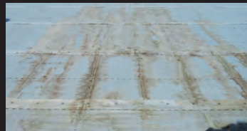
金属屋根の下 ルーフィングの水分による腐模様
