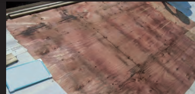
防水層の下 野地合板の腐朽
