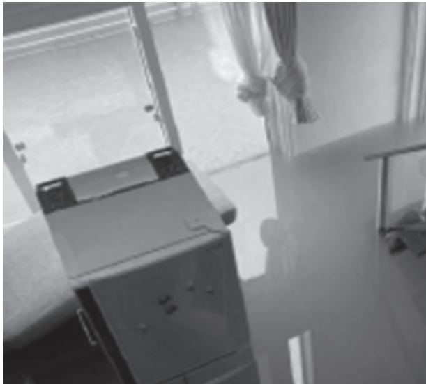
静岡県東部地域における、床上100cm浸水被災の記録写真。壁面には浸水跡が残り、撮影時は、未だ床上浸水状態だった。応急修理を要する工事項目を中心に詳細に記録をとり、工事見積書を用意する。
