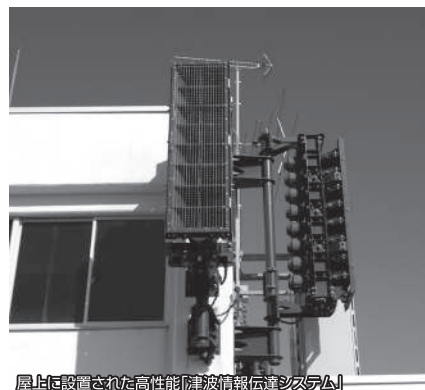
屋上に設置された高性能「津波情報伝達システム」
