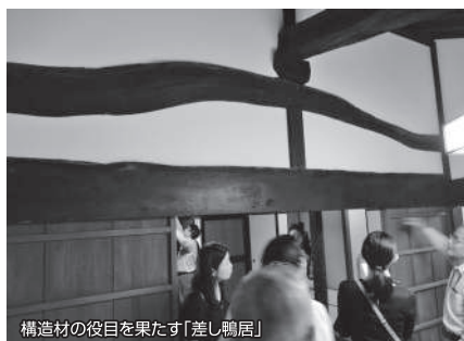
構造材の役目を果たす「差し鴨居」
