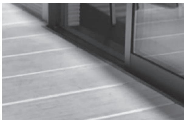
画像ではわかり難いが、サッシの敷居とウッド調デッキ床面は、段差の無い納まりになっている。空間構成は、こうした細部の仕上がりに拘ることで具現化される。
