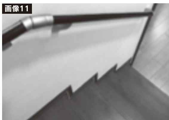
バリアフリーブースにある階段の展示。良く見ると手すり上端と幅木の表面に蓄光材(あかりサポート)が施されており、消灯時でも、その位置を視認できます。これは高齢者配慮に留まらず、災害時避難にも役立ちます
