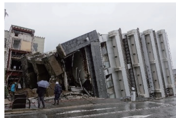
建築物の転倒被害
