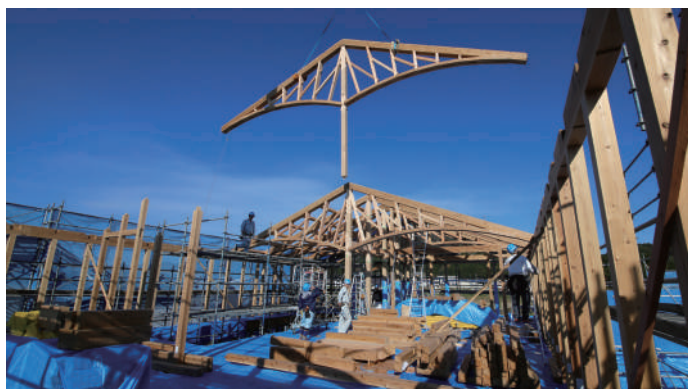
柱を中心に左右に均等に広がる形状に組み上げたものを、クレーンで吊り上げて設置する方法がとられた
