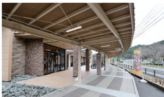
通路は片側だけの柱構造
