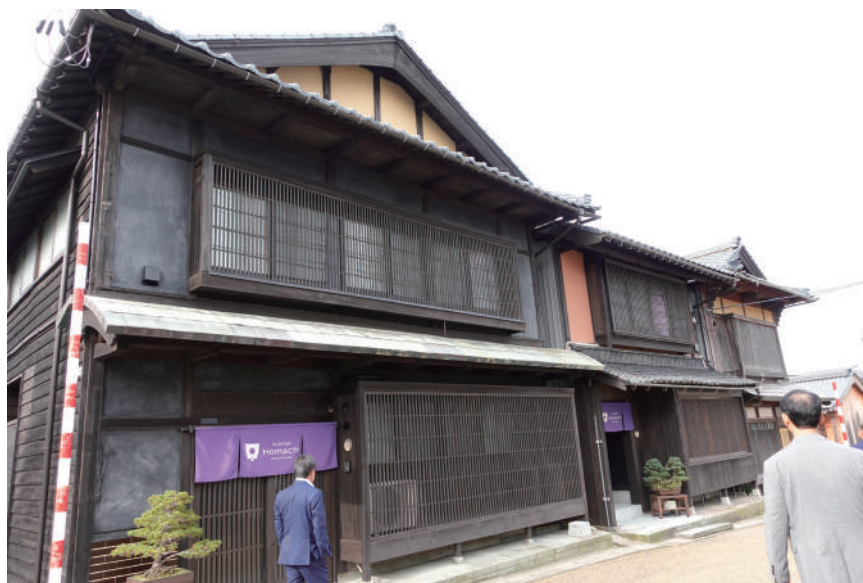
三国湊でしか見ることができない、切妻造妻入の主体部の前方に平入の表屋を付けた「かぐら建て町家」をホテル棟にリノベーション
