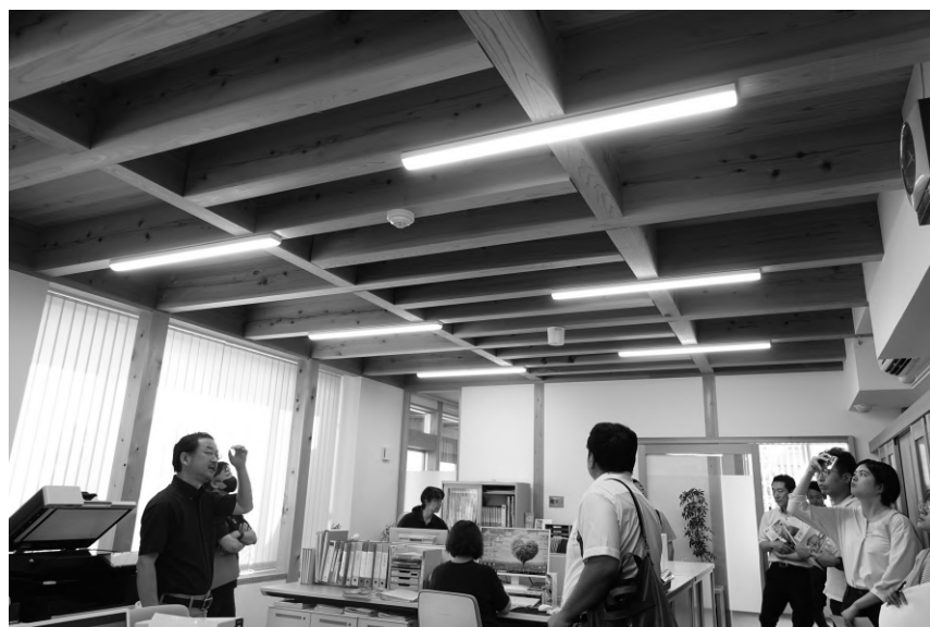
1階事務室。レシプロカル構造の床組を現しとしました。部材同士の接合は市販品の梁受け金物を使用し、プレカット加工で対応可能な形状。
