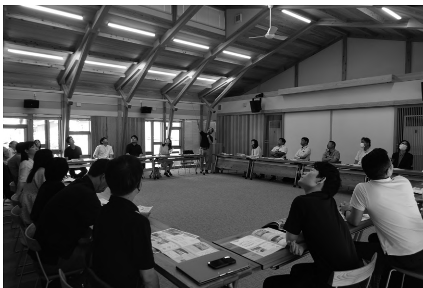
大会議室の多角形アーチ構造はいずれも材長4m材を用いて継手を設け、木材を折れ線状につなげた(3 ヒンジ式折線アーチ構造)。伝統的な構造要素である貫を構造の一部に採用することで、大工の手刻みの技術を生かした木組みとした。
