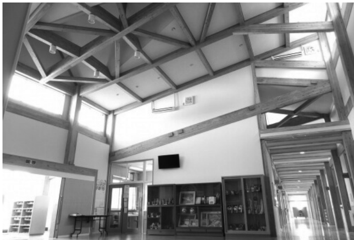
木質二方向ラーメン構造によって大空間を実現
