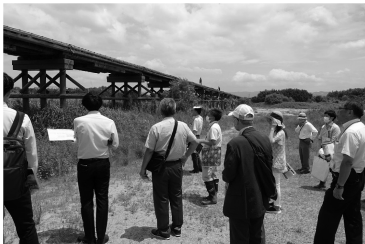
橋脚を見ると上津屋橋が流れる仕組みがよくわかる
