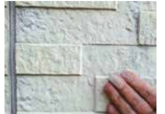
外壁塗料の劣化症状とシーリングの剥離 写真1
