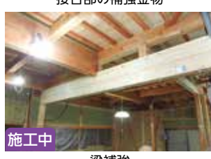
施工中 接合部の補強金物
