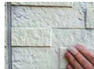
外壁塗料の劣化症状とシーリングの剥離 写真1
