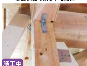
施工中 耐震補強で筋かいを設置
