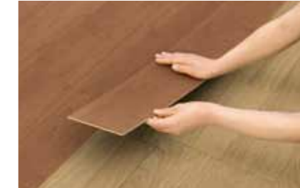
裏面のはく離紙をはがして、上から置くように軽くおさえます。
